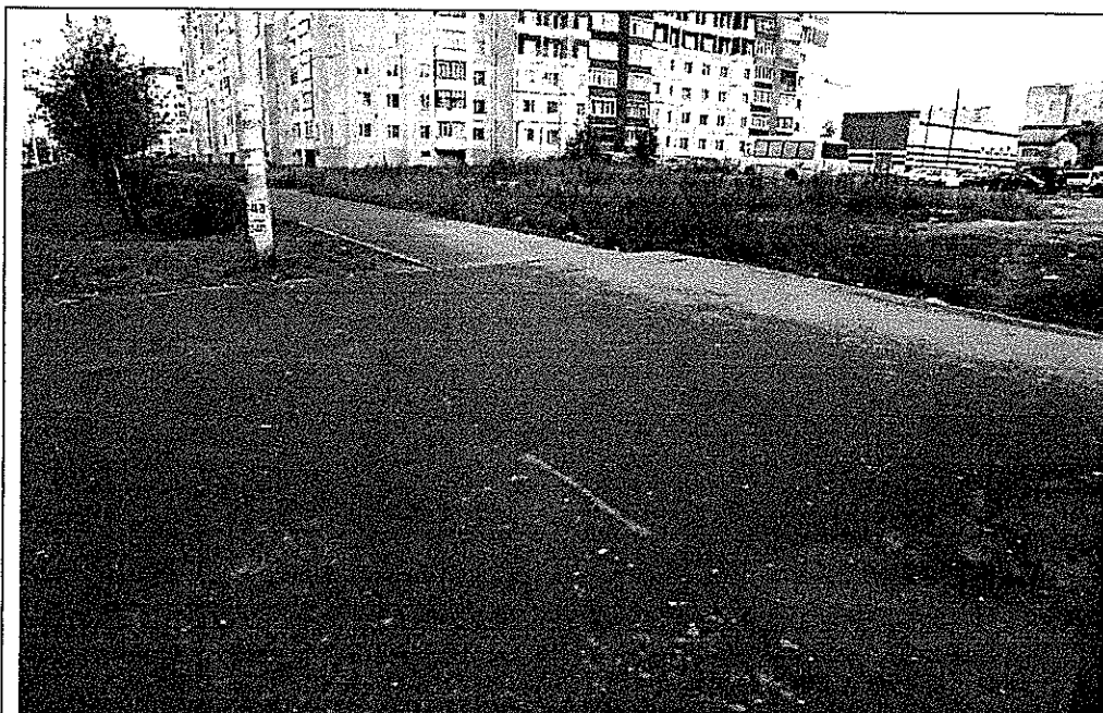
Начало пути от остановки к объекту
